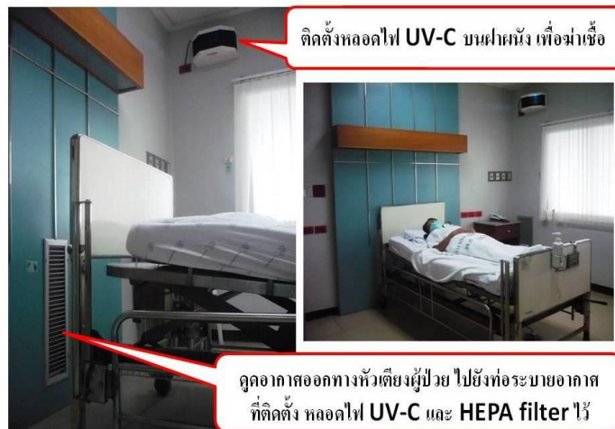
ภาพที่ 3 แสดงตัวอย่างภายในห้องแยก AIIR
