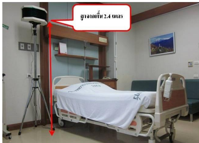
ภาพที่ 4 แสดงการติดตั้งโคมไฟ UV-C ชนิดเคลื่อนย้ายได้
